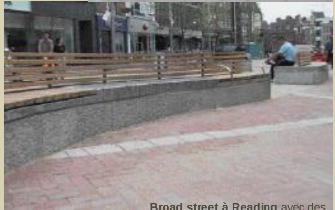
Broad street à Reading avec des assises sur des murets in granit poli de Cornouaille, acier inox et bois Yvyrraro FSC.
